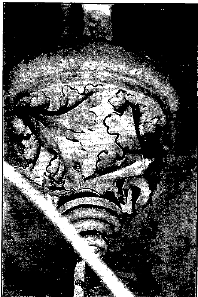
Dosel de arranque de un arco de la crueria de la capilla de la V. de la Soterraña.
