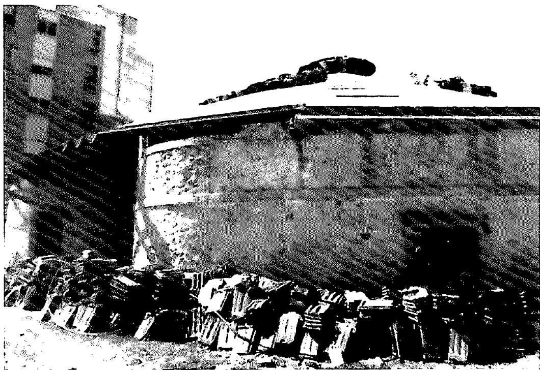
Bodega Redonda (Utiel), construida aproximadamente en 1891, consta de dos partes diferenciadas, una rectangular de dos plantas (entrada principal), y otra constituida por un edificio de forma circular, de techado y entramado metálico igual a una existente en Jerez (son las dos únicas que hay en España).
