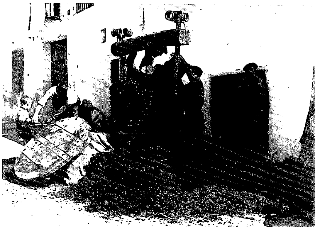
Prensando brisa para extraer el máximo caldo posible. Se trata de una prensa de las "de cuerda", otras muy utilizadas eran las de "jaula".
