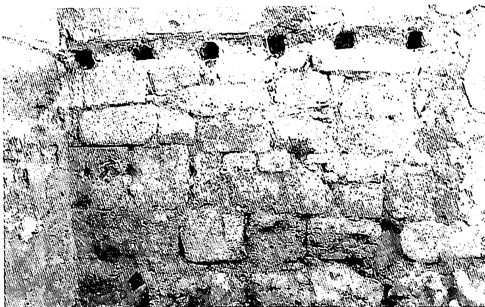
Lám. VII.- Zócalo de sillería de la torre este.
