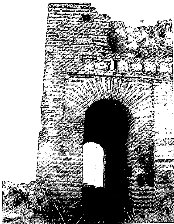
Lám. VIII. - Arco de ladrillo con alfiz de la torre este.
