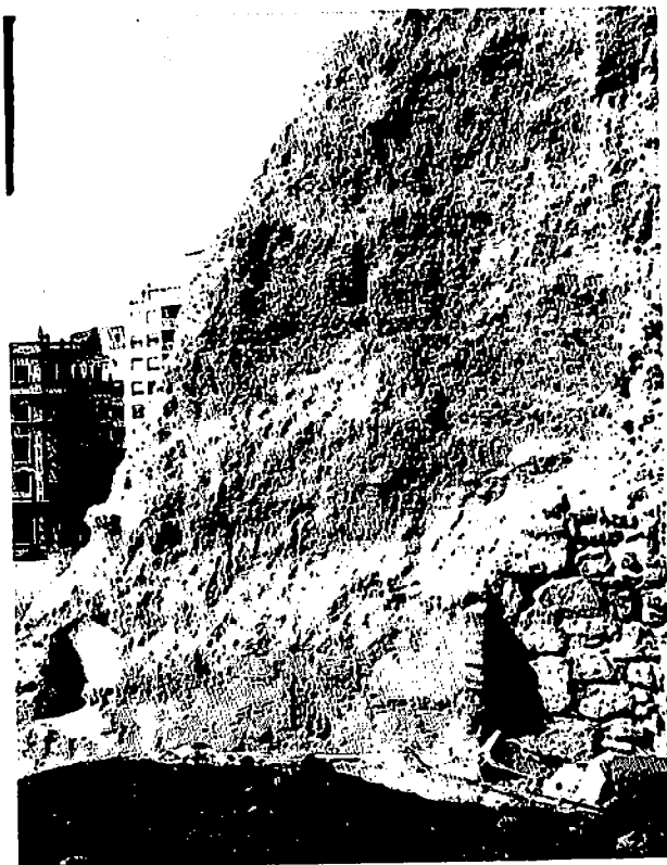
Lám. IV.- Tapial descarnado del ángulo oeste.
