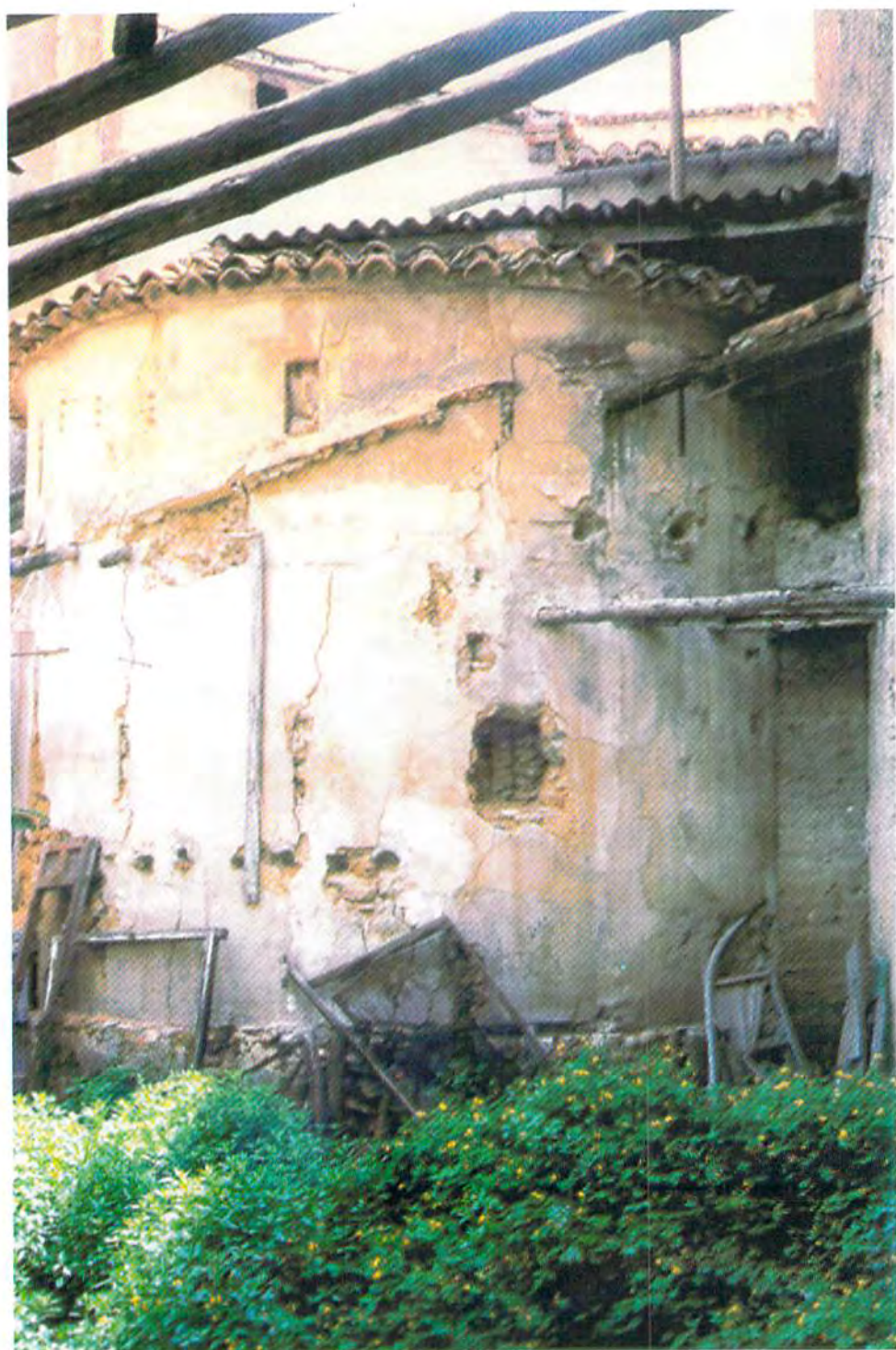
Fig. 5.- Tambor existente junto a la antigua Puerta de Cantarranas
