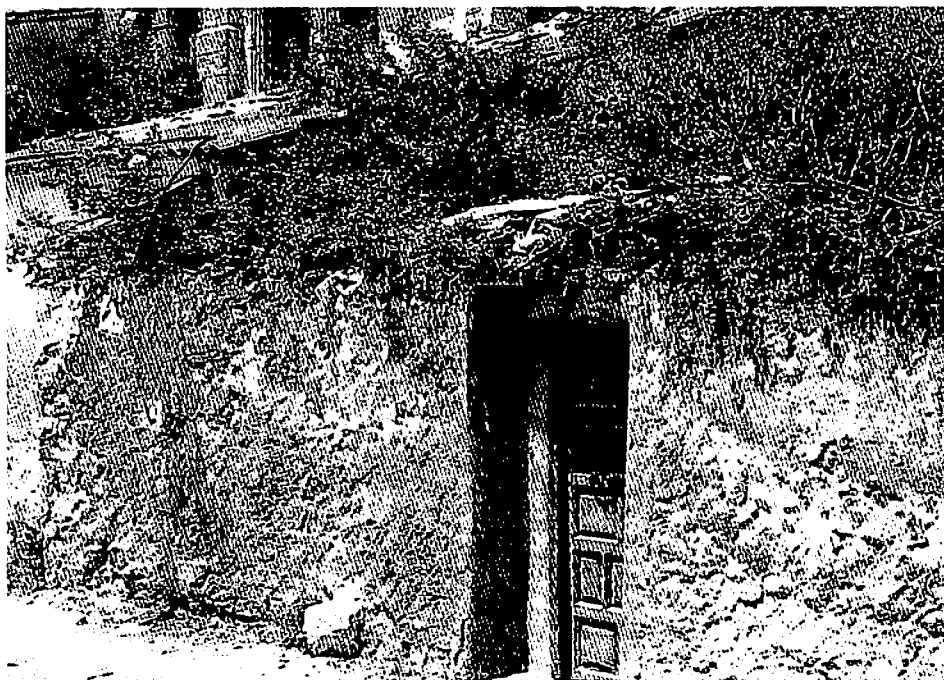
Fig. 10.- Fragmento de tapial "Bajo de los Huertos", actual calle Colegio
