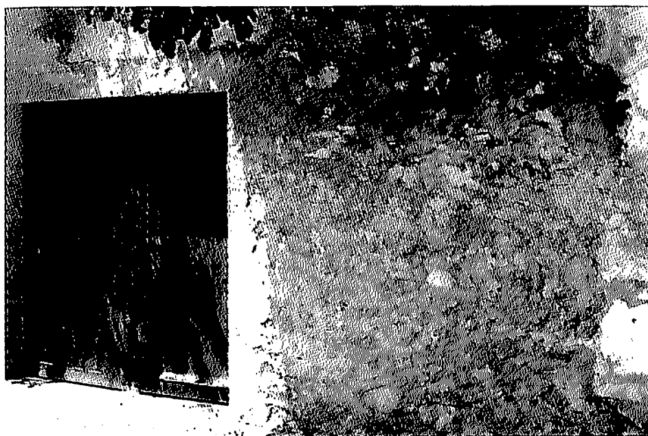
Fig. 9.- Fragmento de tapial "Bajo de los Huertos", actual calle Colegio 77
