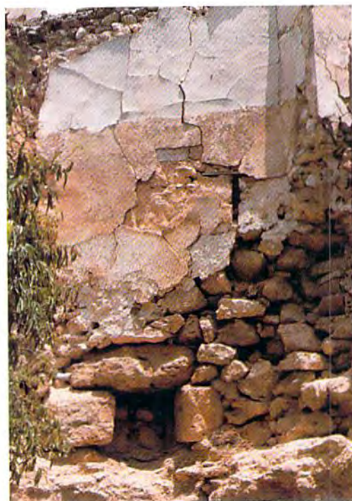
Fig. 8.- Restos de aspillera sobre antiguo desagüe de la Villa. Puerta de Alcalá
