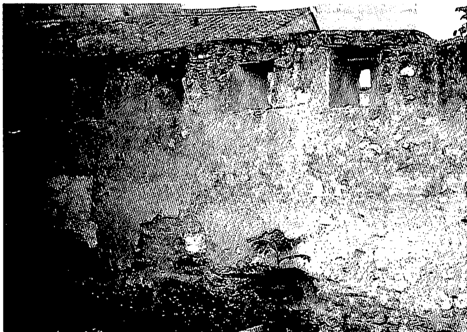
Fig. 6.- Restos de tapial aspillerado junto al Teatro Principal, antiguo sector del circuito Puerta de Madrid - Pozo de la Nieve.
