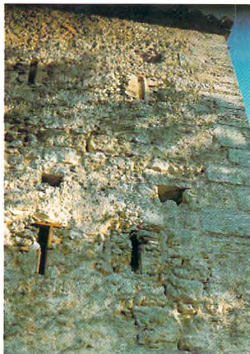
Fig. 12.- Muro aspillerado en planta baja de la iglesia del convento de San Francisco
