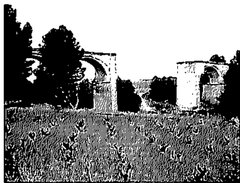
Puente del Ferrocarril Utiel-Baeza sobre la Rambla Bullana. Por estos parajes, la Bullana recibe las aguas de muchas fuentes: Fuente de la Reina, de la Perrilla, Fuente Grande, del Hambre, del Tío Mario, de la Teja, de Cantos, de Gallinas, del Culandrillo, de Hortelanos y un largo etcétera. La Rambla Bullana desemboca en la rambla Albosa en Casas de Pradas, tras pasar el casco urbano de Casas del Rey. Foto Julia Cerrillo.
