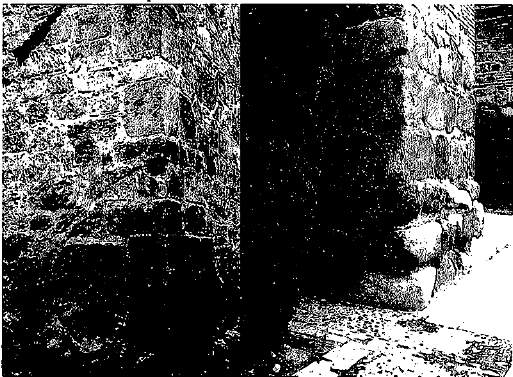
Detalle de los aparejos paralelos de los sillares irregulares y mal encuadrados de una de las torres de la fortaleza de Requena (izquierda) con idéntica tipología a los de otra de las torres de la puerta de la muralla toledana que confronta con el puente de Alcántara (derecha).
