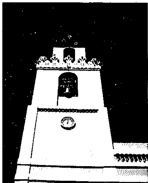
Detalle de la Torre de la Iglesia de las Casas de Utiel
