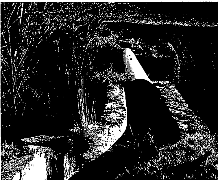
En los alrededores a Calderón, en el Puente de la Casa de los Frailes que cruza la Rambla de la Torrubia, el tubo permite el cruce de la Acequia de Calderón. Anteriormente fue de madera.
