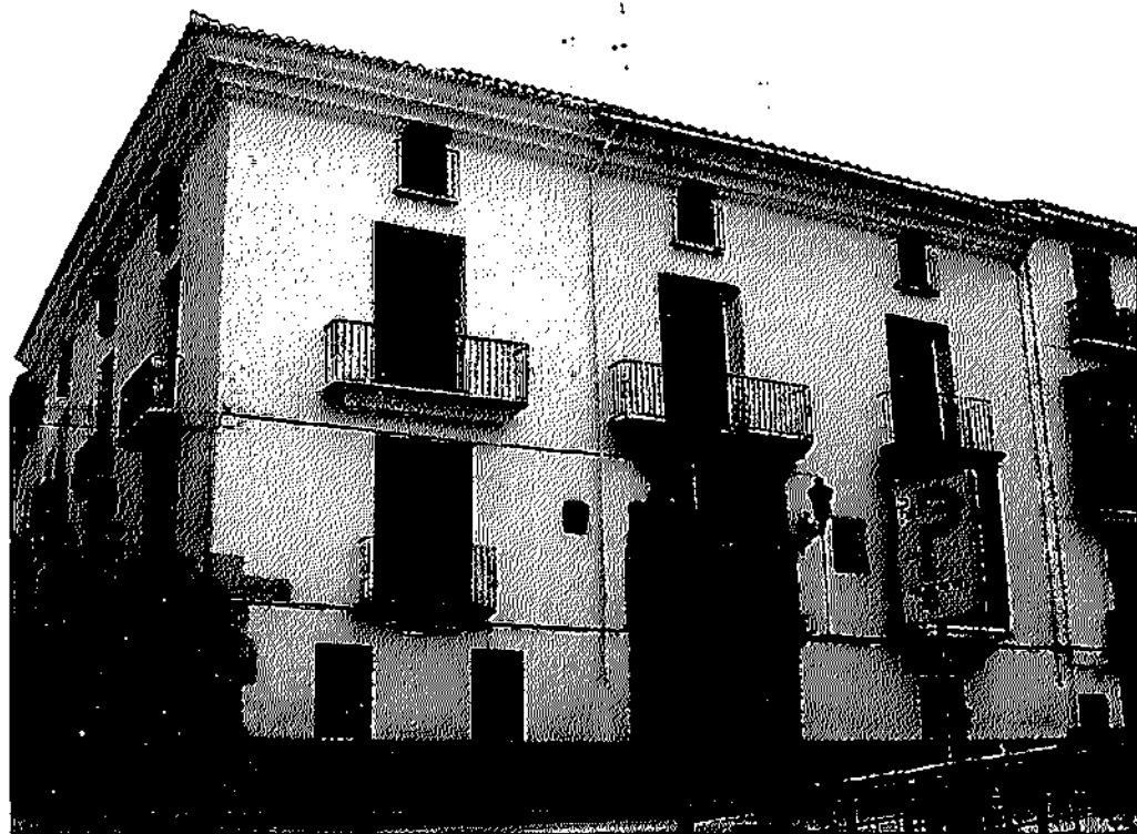
El edificio que hace esquina en las calles San Carlos y San Luis.
