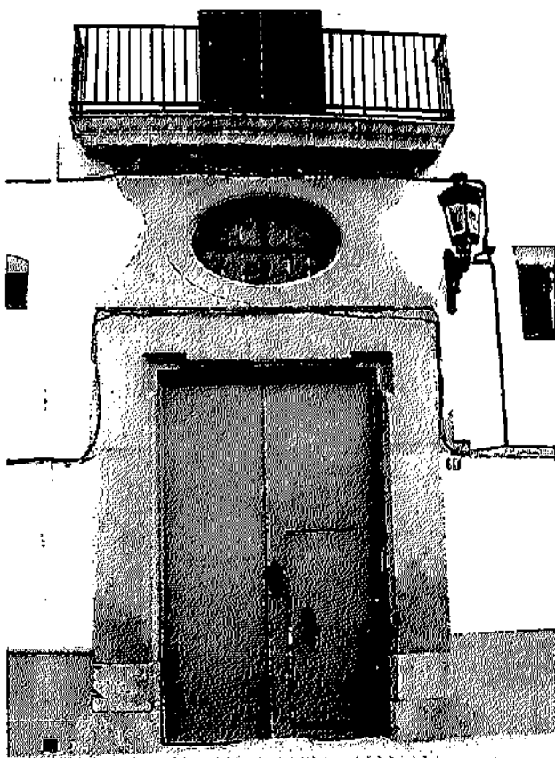
Portada de la casa fechada en 1792, que debió ser la primera en construirse y que presenta una bien delineada portada de piedra que incorpora el óculo característico de iluminación del zaguán e incorpora también en piedra un potente sola balcón.
