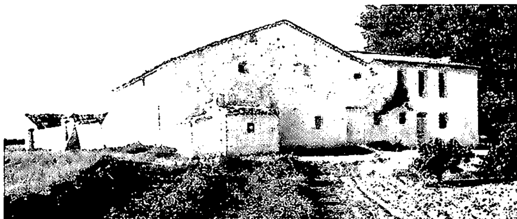
Casa de la Tejería. Construida a comienzos del XIX por don Juan A. Enríquez de Navarra que compró varios lotes del Ardal del Campo, pasó más tarde a manos de los Ruiz Manglano. Es uno de los ejemplos de casa de labor surgida tras la venta de la última gran dehesa concejil en 1812.
