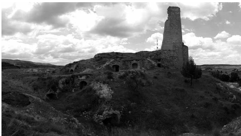
Fig. 11. Vista general del foso norte
