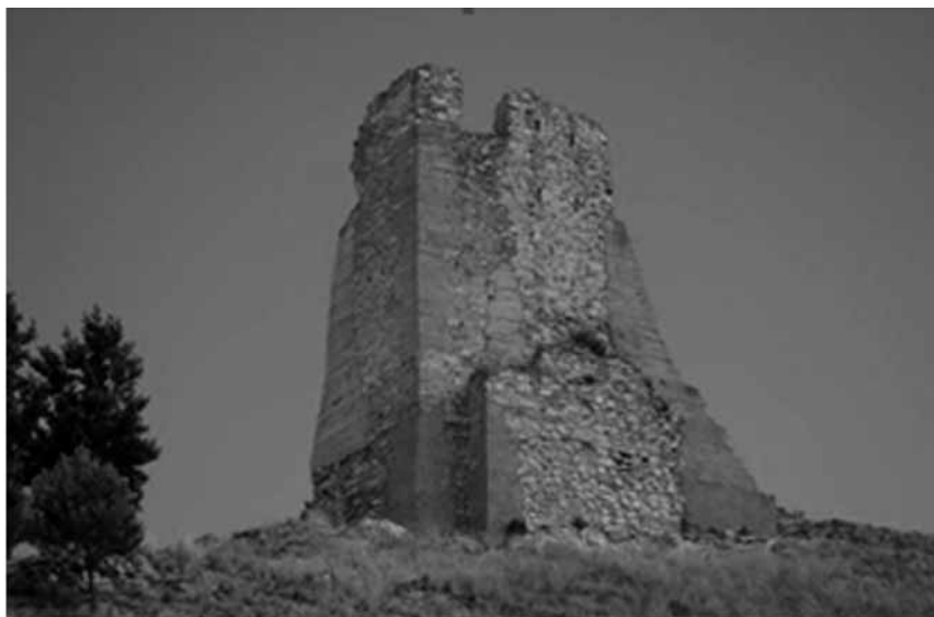
Fig. 4. Imagen exterior de la torre.
