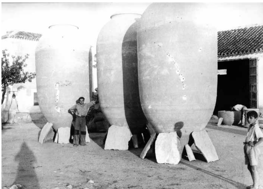
Tinajas sujetas por retejones o trozos de tinajas rotas, secándose al sol en el patio. Al fondo a la derecha se ve la puerta del obrador. Villarrobledo (Albacete) mediados siglo XX. Foto anónima.
