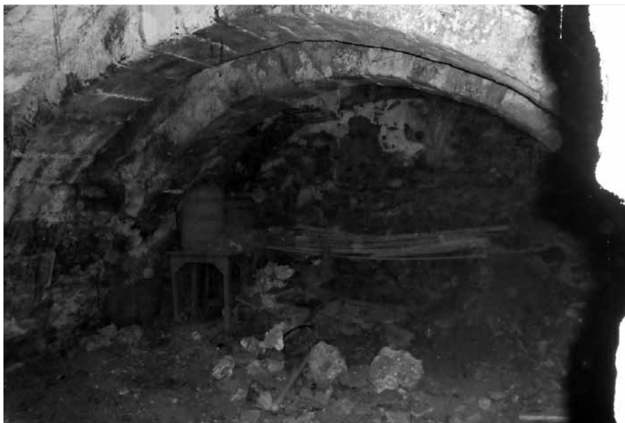
Fig. 5: Cueva de la Casa de la Cadena, edificada a la vez que la vivienda en el siglo XVI. En la fotografía se puede vislumbrar el pasillo sostenida por la bóveda de cañón con tres arcos de medio punto, tapiado el fondo en el siglo XIX cuando se utilizó de almacén de bebidas. Aún se ven algunos toneles de cerveza guardados.
