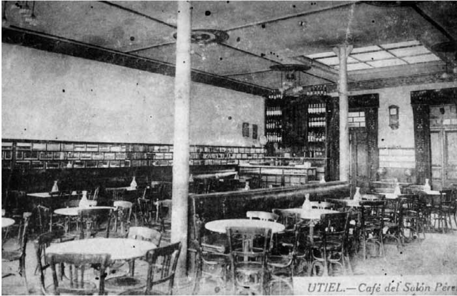
Fig. 1: Fotografía de principios del siglo XX. Vista del salón principal, estando en primer plano las dos columnas de acero, y al fondo la disposición original de la barra de servicio y colección de licores.
