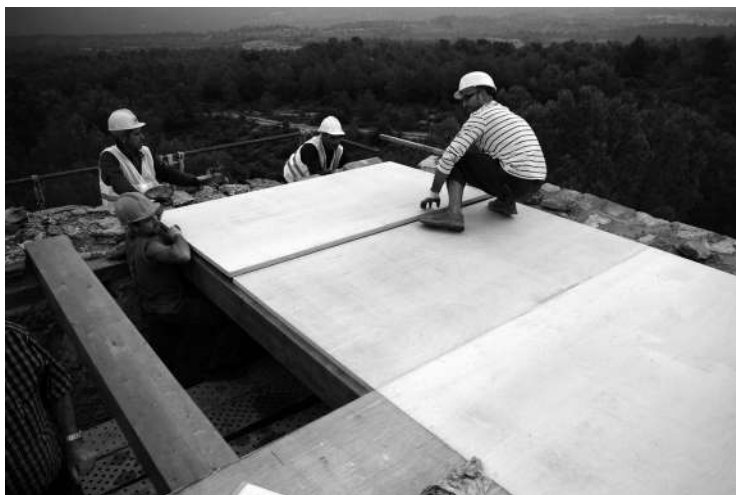
Reconstrucción del forjado de madera de la cubierta (foto autores)
