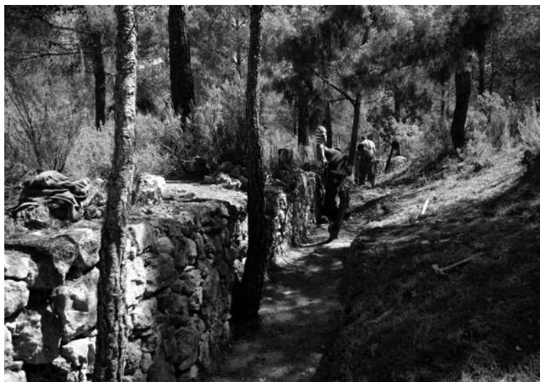
Recuperación manual del fondo de trinchera (foto autores)
