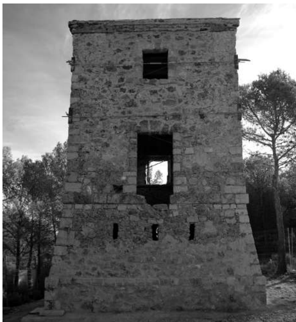
Torre del Telégrafo en fase de restauración (foto autores)
