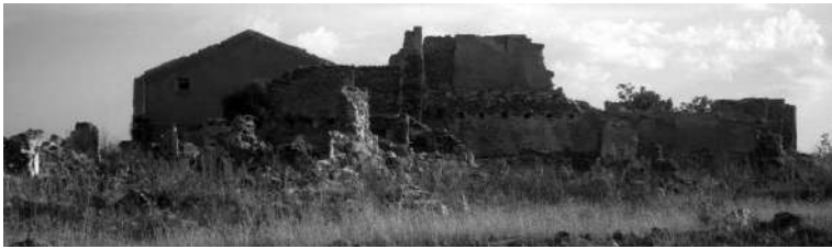
Vista sudoccidental de las Casas de Lázar. Se pueden reconocer cuatro viviendas y unos trullos que actualmente se encuentran casi derruidos. Estas viviendas junto con las tierras de su entorno han sido propiedad de la poderosa familia Enríquez de Navarra que construyó aquí una ermita. Tras el desmantelamiento de la ermita, la campana se colocó en la Iglesia de Casas de Eufemia y la Virgen de la Encarnación se convirtió en la patrona de la aldea vecina de Los Duques. Fotografía: Diego García Monteagudo, agosto de 2013
