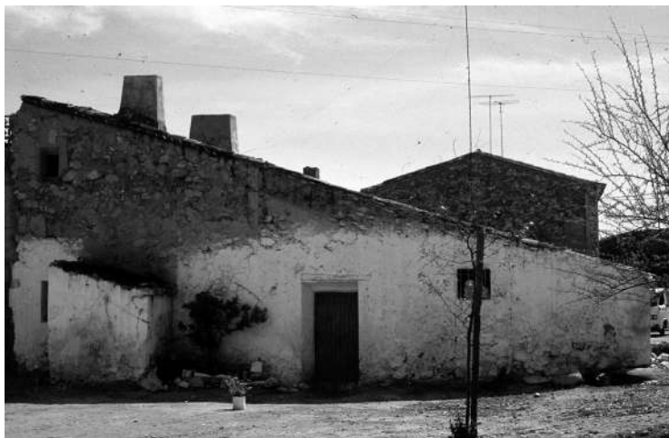
Casa con horno al exterior
