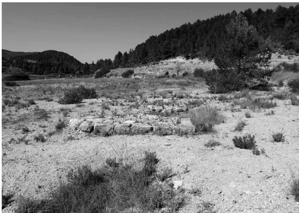
Figura 7. Situación de abandono inminente: crecimiento de la vegetación, derrumbes, coloración y erosión de los bloques de caliza.
