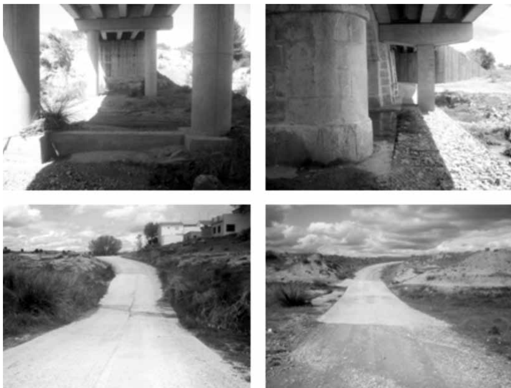
Figura 12. Principales obras sobre el arroyo de la Esteruela. Puente sobre la CV-455 (arriba a la izquierda), puente sobre la N-322 (arriba a la derecha) y pasos asfaltados en el entorno urbano de Casas de Eufemia (abajo a la izquierda) y Los Duques (abajo a la derecha).
