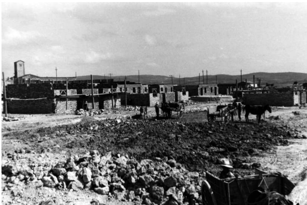
Imagen 85: Barrio de las 103 Viviendas, en construcción (1956)
