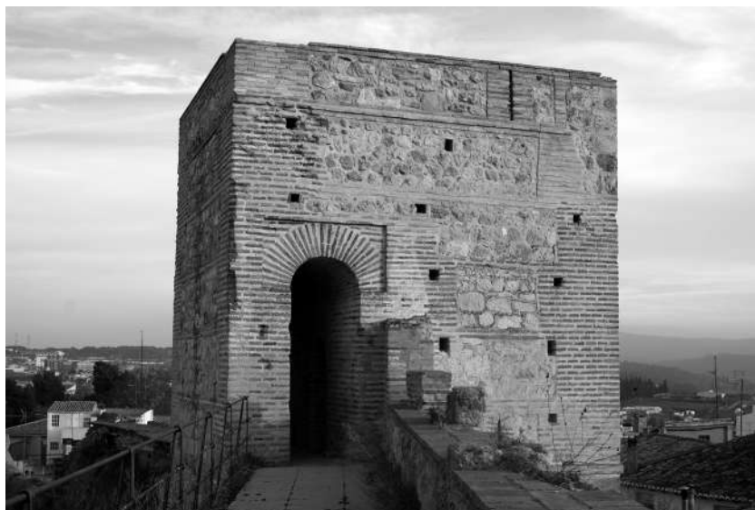
Requena: torreón del muro que forma atajo
