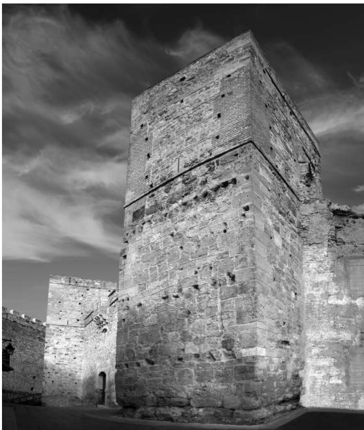
Muro que cierra la proa del extremo norte del recinto requenense, haciendo atajo entre dos cortinas.
