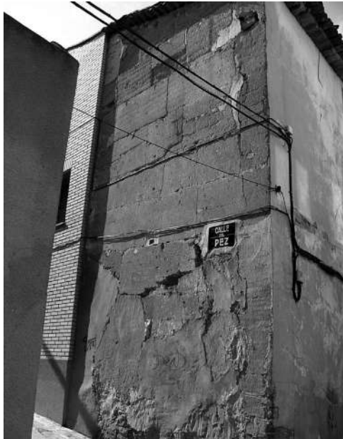
Fig. 2. Vivienda de tapial en C/ del Pez. Casco Histórico de Utiel.
