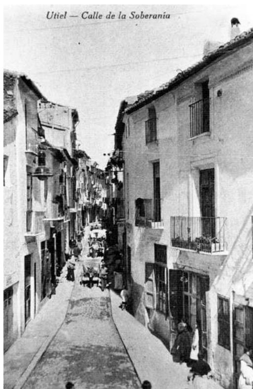
Fig. 14. La calle, derribada la puerta.
