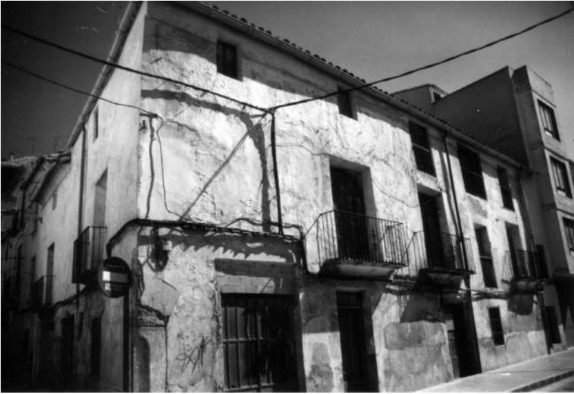
Fig. 5. El inmueble en C/ Camino, antes de su demolición.
