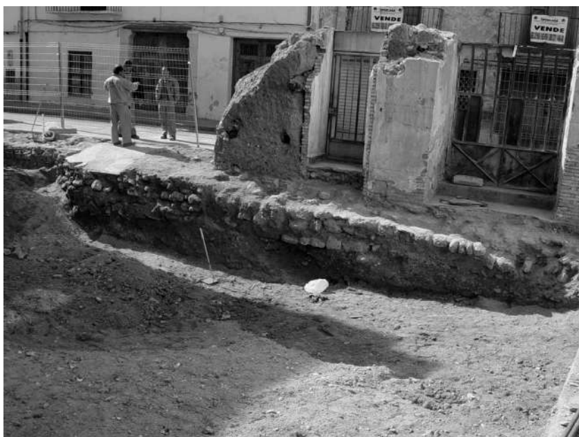
Fig. 7. Zócalo y restos del alzado de la muralla.
