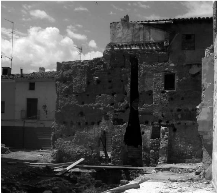
Fig. 19. Estado de la muralla tras los derribos correspondientes.
