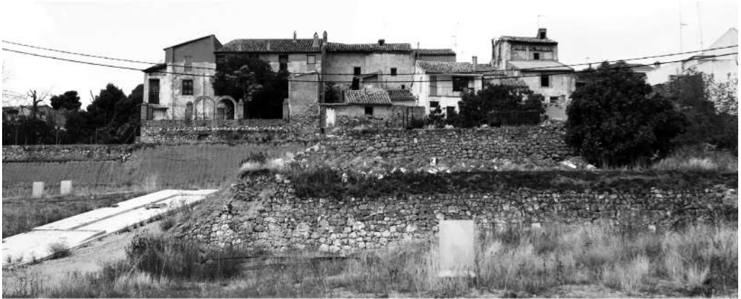
Estructuras vernáculas de piedra en seco devoradas por el denominado PAI del Batanejo (Guimaraens&Navalón, 2015).
