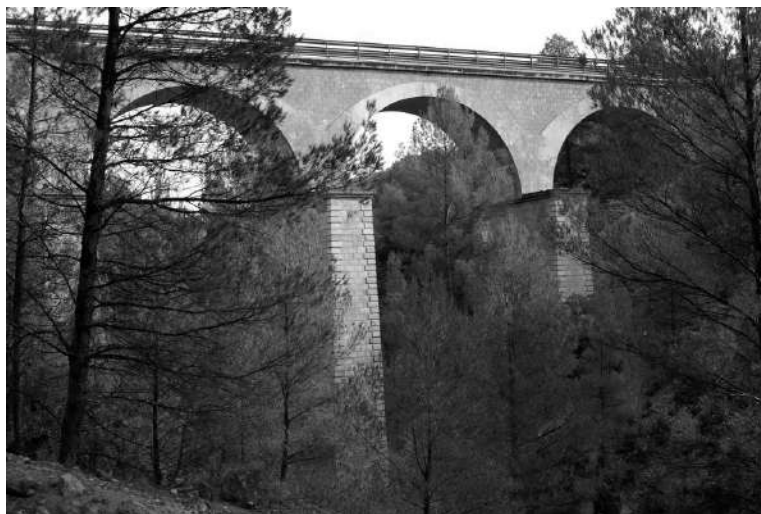
Imagen 8. Viaducto barranco del Moro
