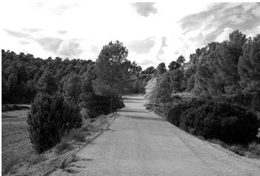
Imagen 13. Vía explanada en Peñón Hundido
