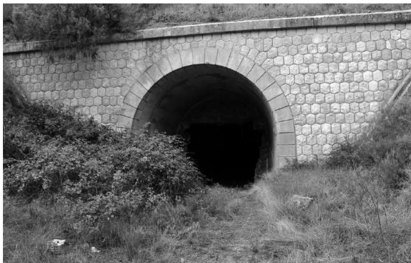
Imagen 9. Túnel 25. Las Covatillas
