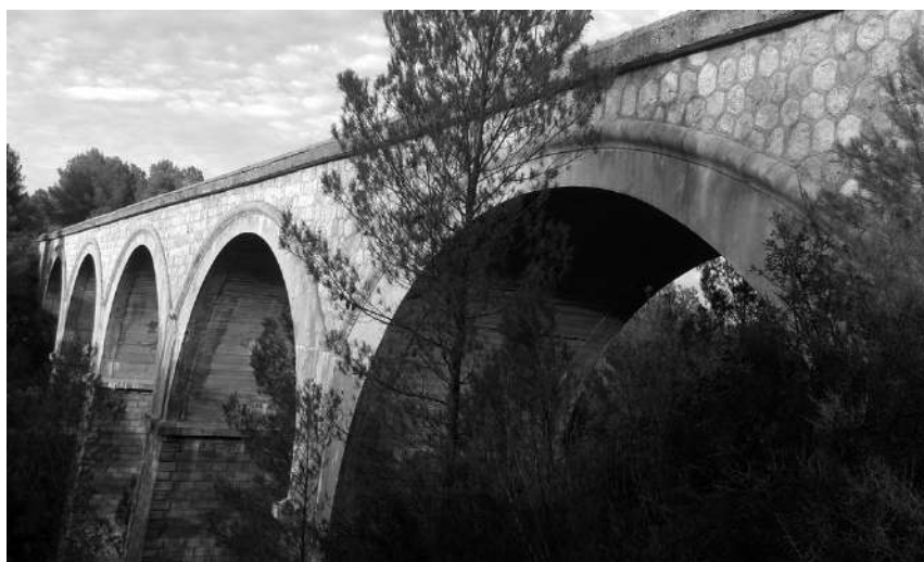
Imagen 14. Viaducto del barranco Varejo
