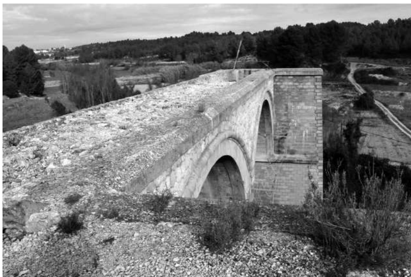
Imagen 1. Puente del Rebollo sobre la rambla Albosa
