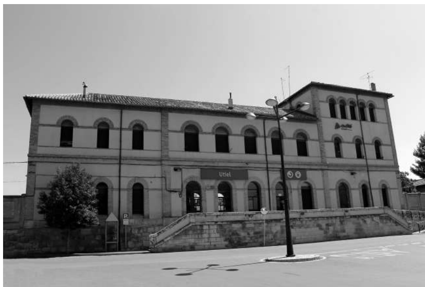
Imagen nº 3. Estación de Utiel. Edificio de viajeros. Foto J. Alabau
