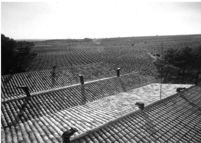
Fig. 13. Sistema de ventilación en las naves de crianza.
