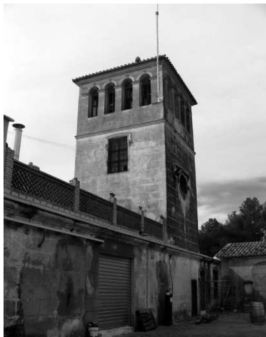
Fig. 17. Torre, en la parte posterior de la bodega de crianza.
