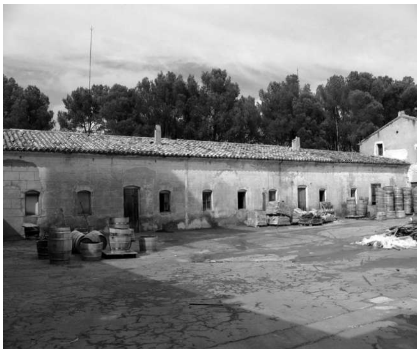
Fig. 19. La casa de vendimiadores, recayente al patio interior.
