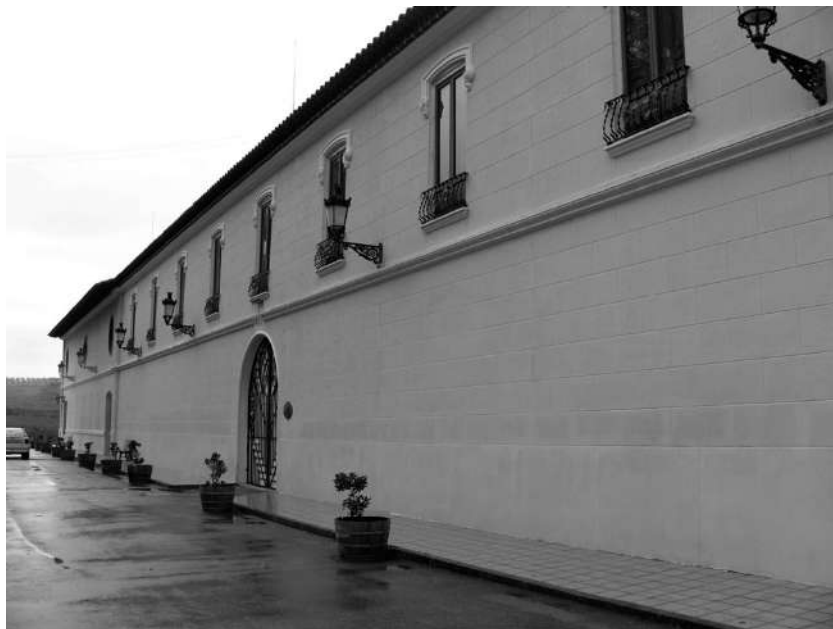
Fig. 10. Bodega de elaboración. Fachada Este.
