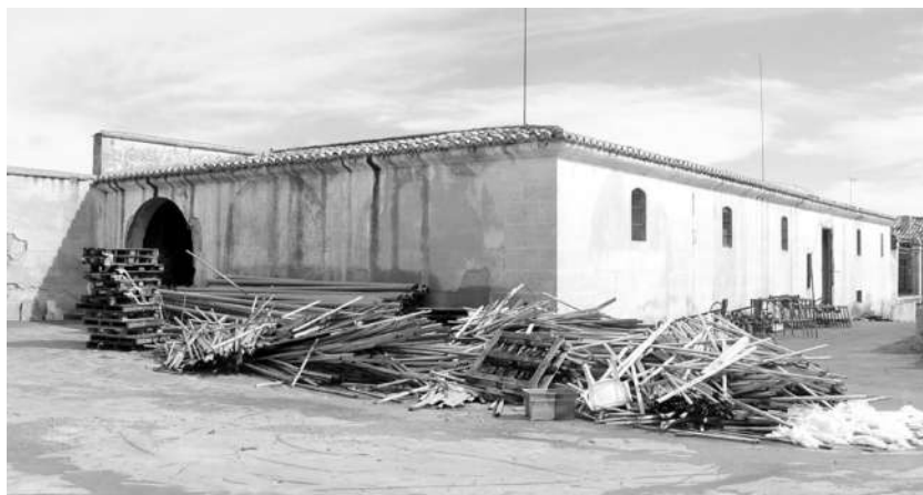
Fig. 21. Almacén de aperos de labranza en el patio interior.
