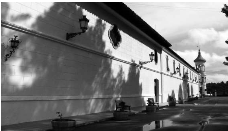
Fig. 16. Fachada Este de la bodega de crianza.
