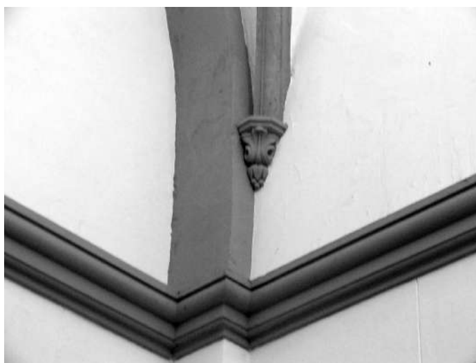
Fig. 15. Detalle de la bóveda; cornisa, arco fajón y arranque de un nervio.
