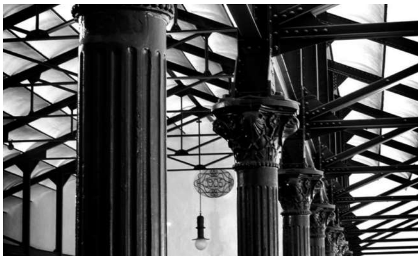
Fig. 12. Columnas estriadas de fundición, capiteles y cerchas roblonadas.
