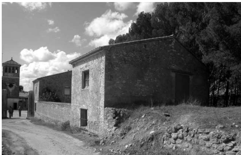
Fig. 20. La vivienda de caseros.
