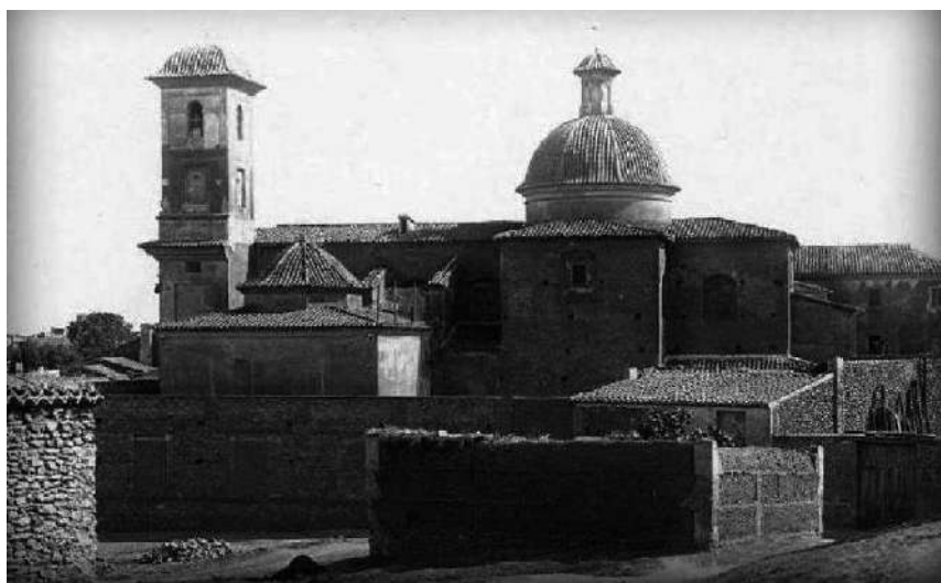
Escuelas Pías y Barriete del Parchel (Utiel). Construcciones de tapial como el antiguo convento del siglo XVIII y otras edificaciones de menor categoría que utilizan el tapial y la mampostería de “muro fino”.
