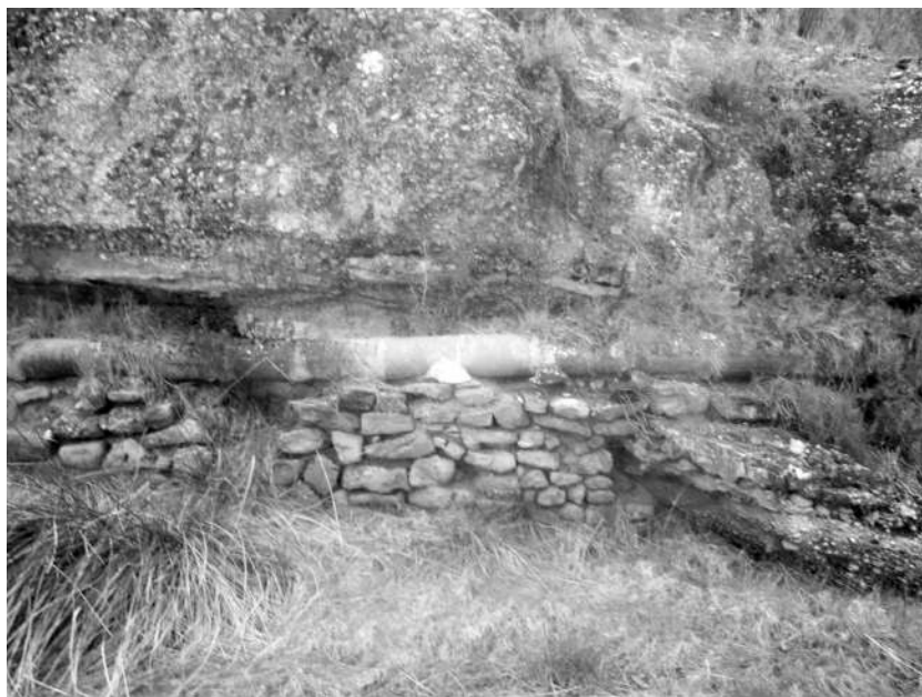
Figura 7. Tramo de tubería artificial bien conservado entre la fuente de la Esteruela y la presa de este sistema de riego válido para indicar la ruta por este arroyo. Fuente: Diego García Monteagudo, 2011
