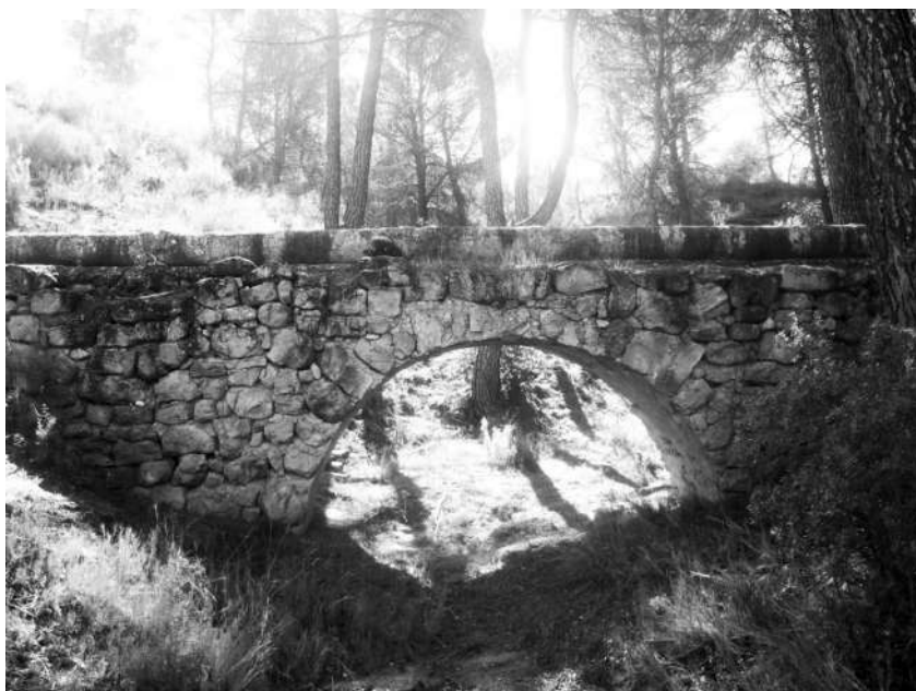
Figura 6. Tramo de tubería cercano a la presa de Marín. La tubería salva un pequeño reguero que desemboca en el arroyo de la Esteruela. Fuente: Diego García Monteagudo, 2011
