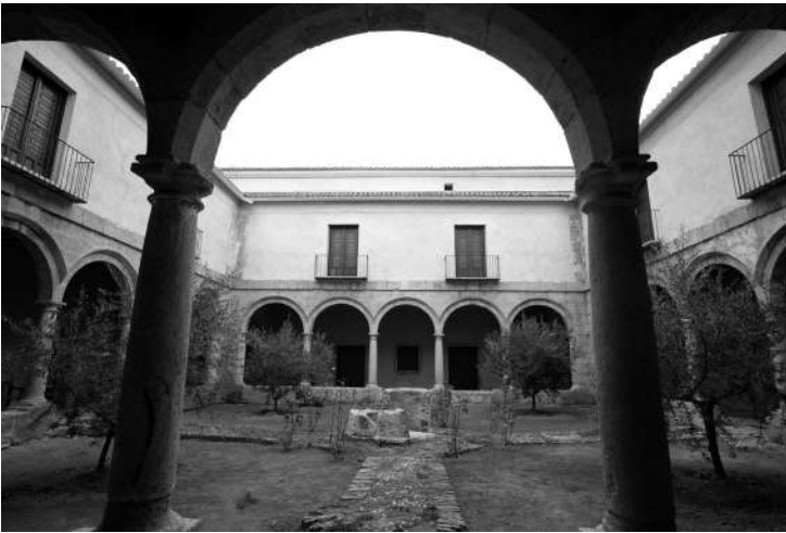
Claustro Convento de San Francisco
