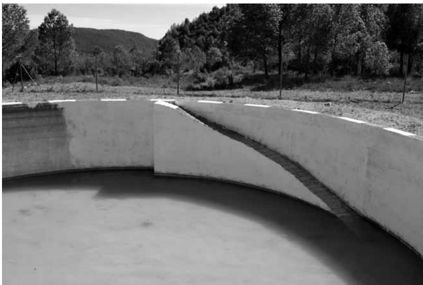
Imagen 1. La adecuación de las balsas de incendios con rampas de salida es una medida imprescindible para evitar ahogamientos de fauna.
