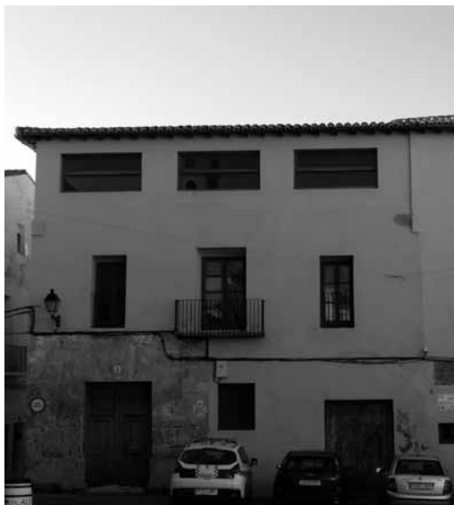
Imagen 25. Edificio del barrio de La Villa citado en los antecedentes de este trabajo, en el que se observó un vencejo entrando al nido a finales de agosto de 1995.
