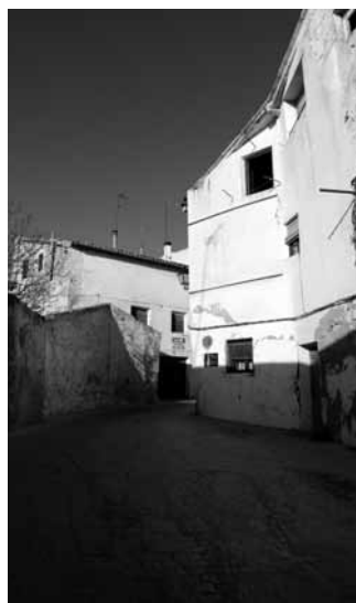
Imagen 15. Espacio abierto de la Puerta de Alcalá. El edificio del fondo (nº 54) alberga una importante colonia de vencejo pálido.
