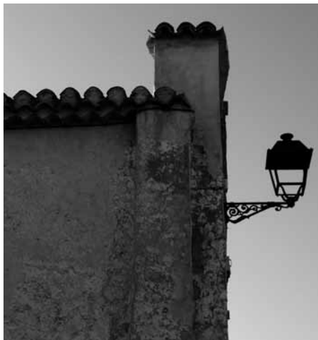
Imagen 42. Detalle del alero del tejado del mismo edificio. Presenta todos los huecos tapados con cemento, lo cual imposibilita el asentamiento de cualquier pareja de vencejo.
