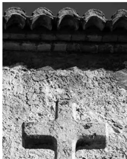
Imagen 40. Detalle del alero del mismo edificio. Todos los huecos están sellados, lo cual es causa de la ausencia de la especie en este tejado.
