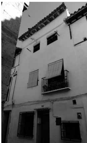
Imagen 17. Edificio de Somera nº 28, en cuyo alero nidifican varias parejas de la especie.
