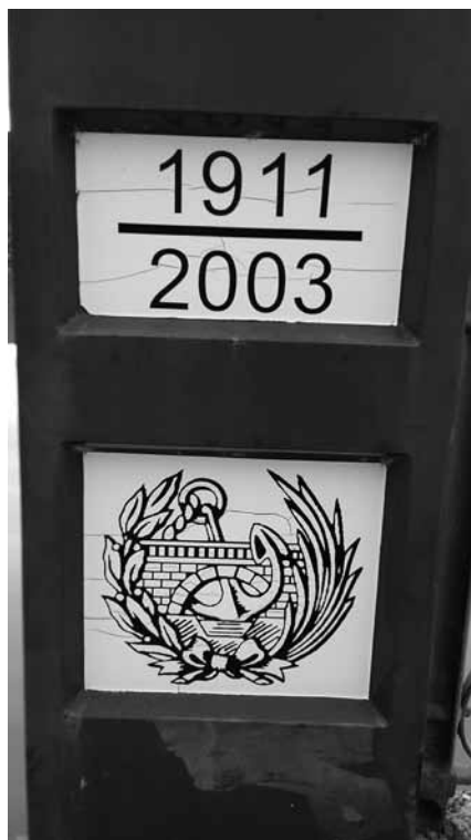
Fig. 22.5. Puente de Cofrentes. Placa con fechas de construcción y rehabilitación
