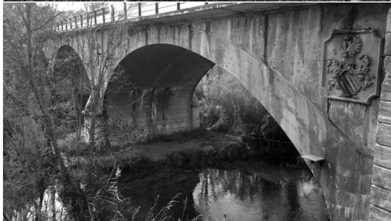
Fig. 21.6. y Fig. 21.7. Puente sobre río Cabriel en Fuente Podrida - Villatoya
