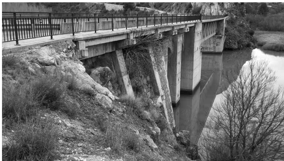
Fig. 6 Puente de Cofrentes en la actualidad
