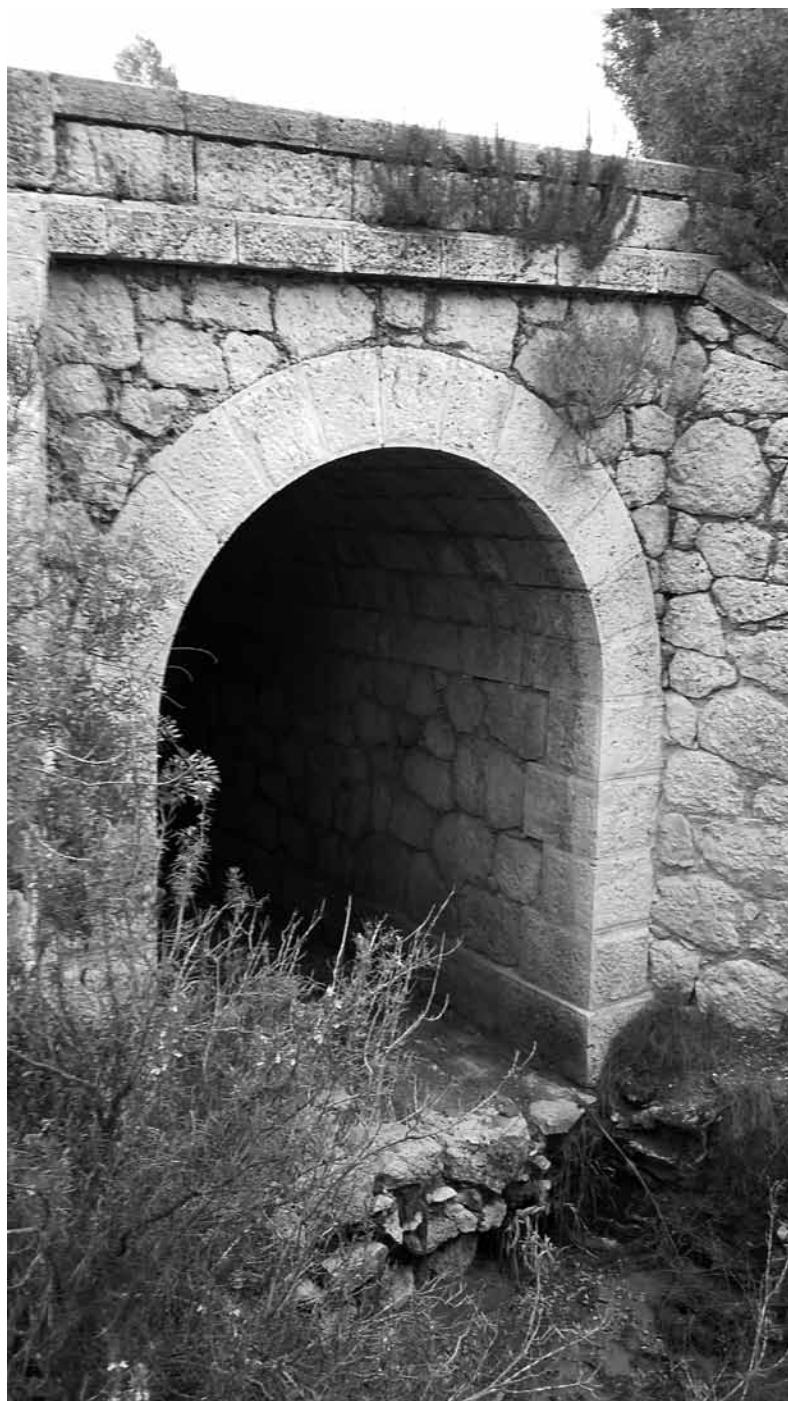
Fig. 22 Carretera Requena-Cofrentes. Alcantarillas-Puente
