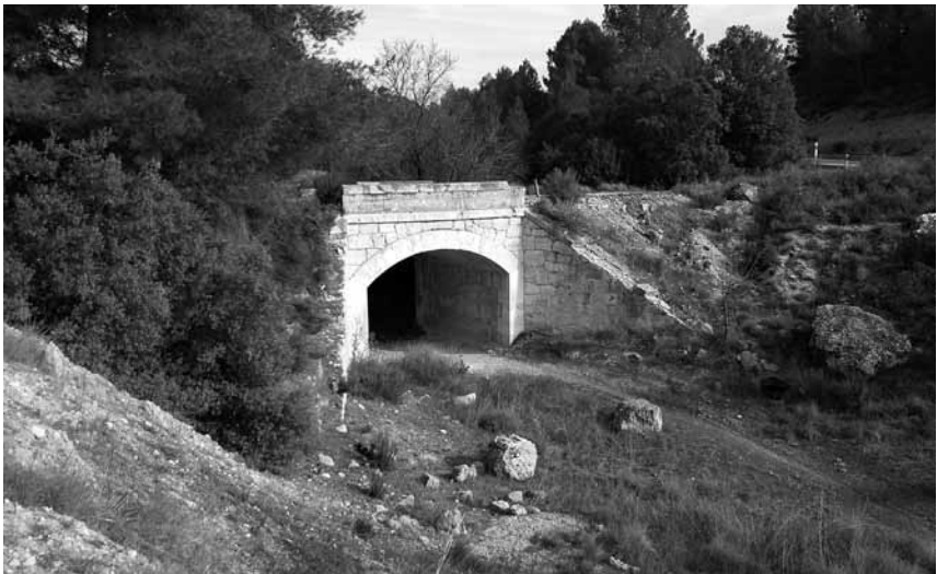
Fig. 21.2. Carretera Requena- Casas Ibáñez. Alcantarillas Puente
