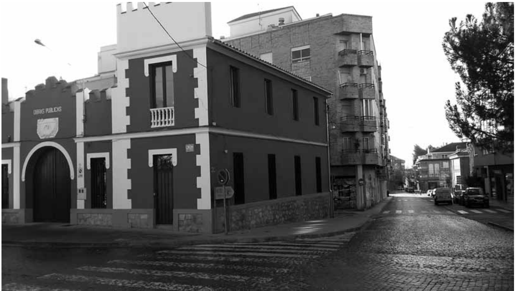
Fig. 12. Edificio Obras Públicas. Requena. Avenida General Pereyra
