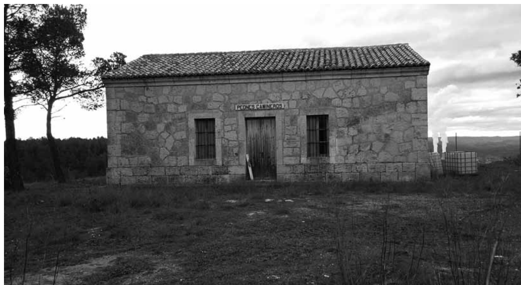
Casilla peones camineros carretera Requena- Cofrentes. Inicio Chirrichana
