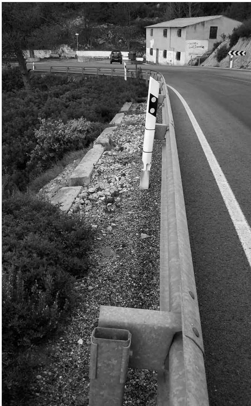
Fig. 7.1. Asfaltado actual sobre antigua carretera Requena- Cofrentes
