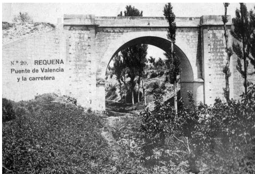
Fig. 20 Requena. Puente de Valencia. Carretera Madrid- Valencia
