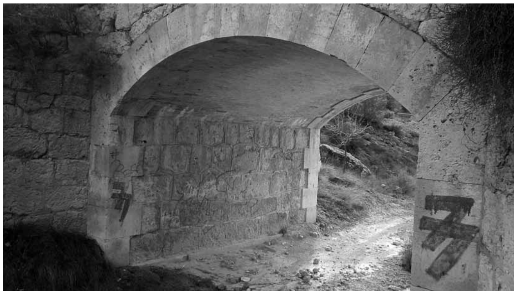
Fig. 21.3. Alcantarilla en carretera Requena - Casas Ibáñez
