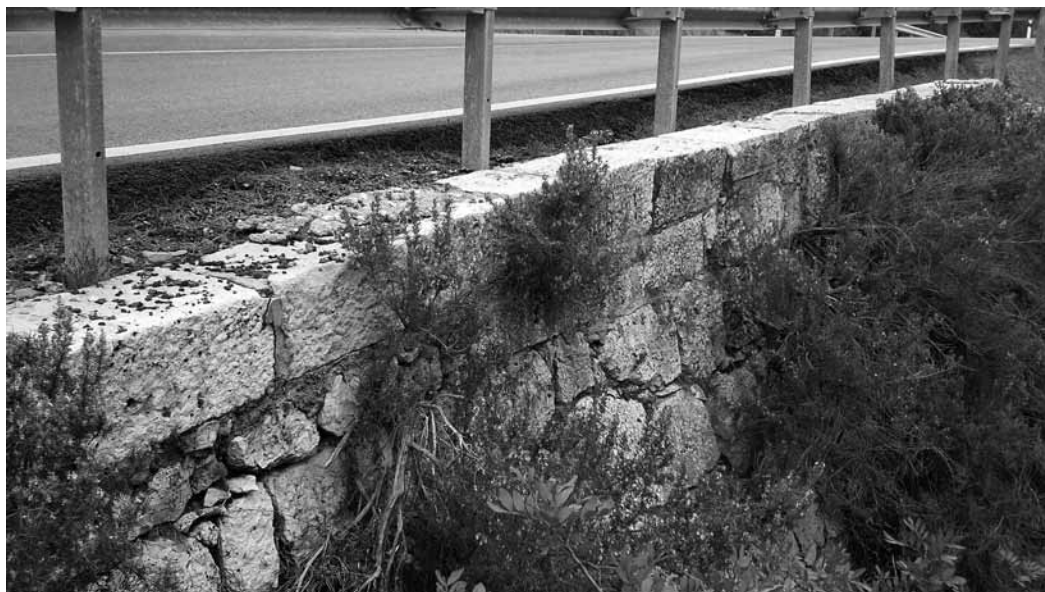
Fig. 22.4. Muro de la antigua carretera de Requena a Cofrentes
