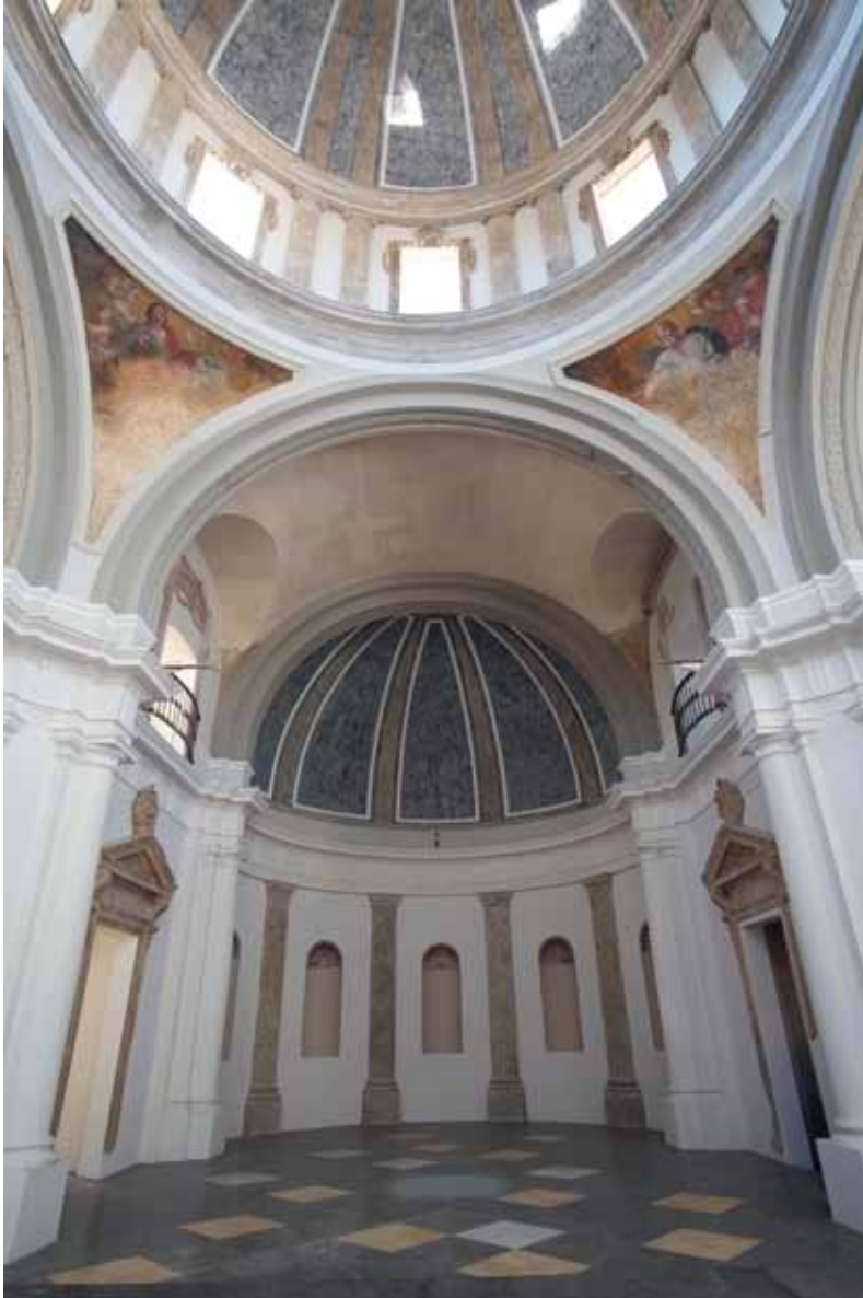
Fig. 6. Vista del interior de San Nicolás
