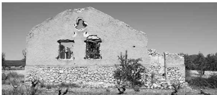
Fig. 24. Edificio nº 2, fachada sur. (Foto José M. Martínez)
