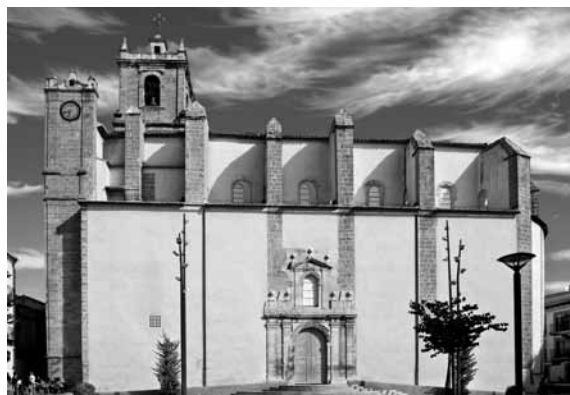
Fig. 8. Fachada sur de la Iglesia de la Asunción de Ntra. Sra. (Ayuntamiento de Utiel)
