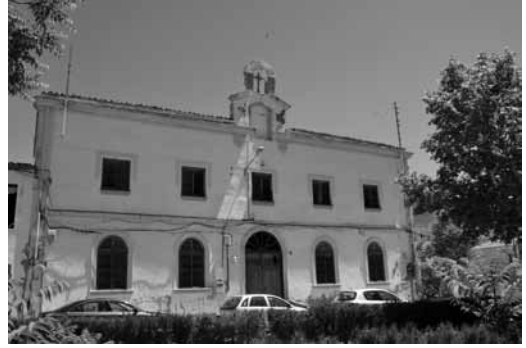
Fig. 16: Asilo. Estado antes de su rehabilitación. (Foto José M. Martínez).
