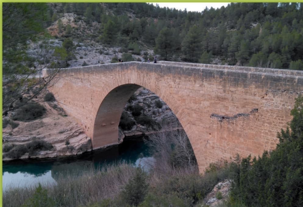
Fotografía 1. Puente de Vadocañas (Venta del Moro)
