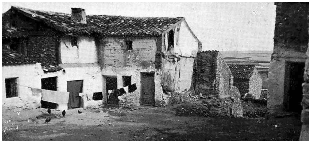
Fig. 4: Derribos entre la Calle Calderería y Mesón dentro de la puebla medieval.
