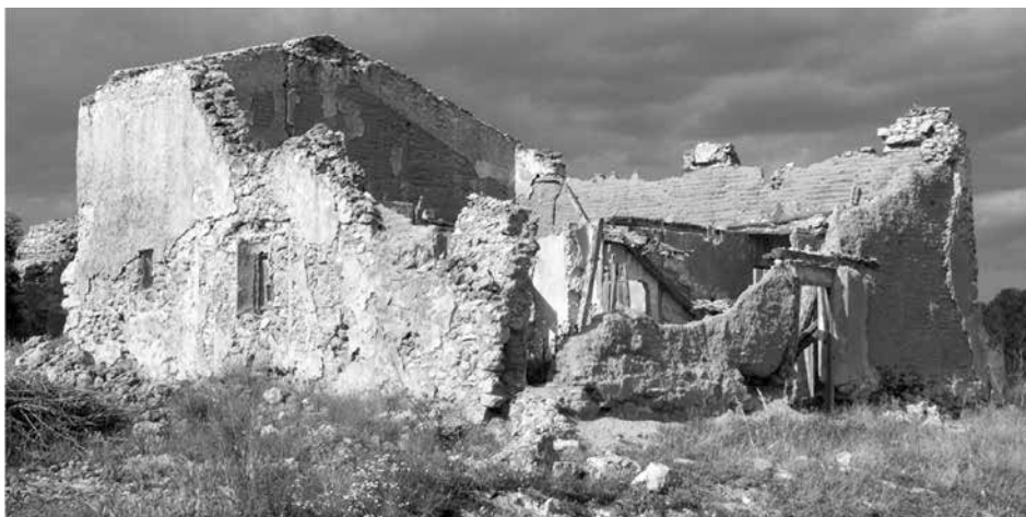
Casa de la Sevilluela, cabeza de una antigua dehesa en término de Venta del Moro. Tras quedar deshabitada las aguas y el viento se han encargado de destruir su débiles paredes hechas de barro. (Piquerías, 2018).
