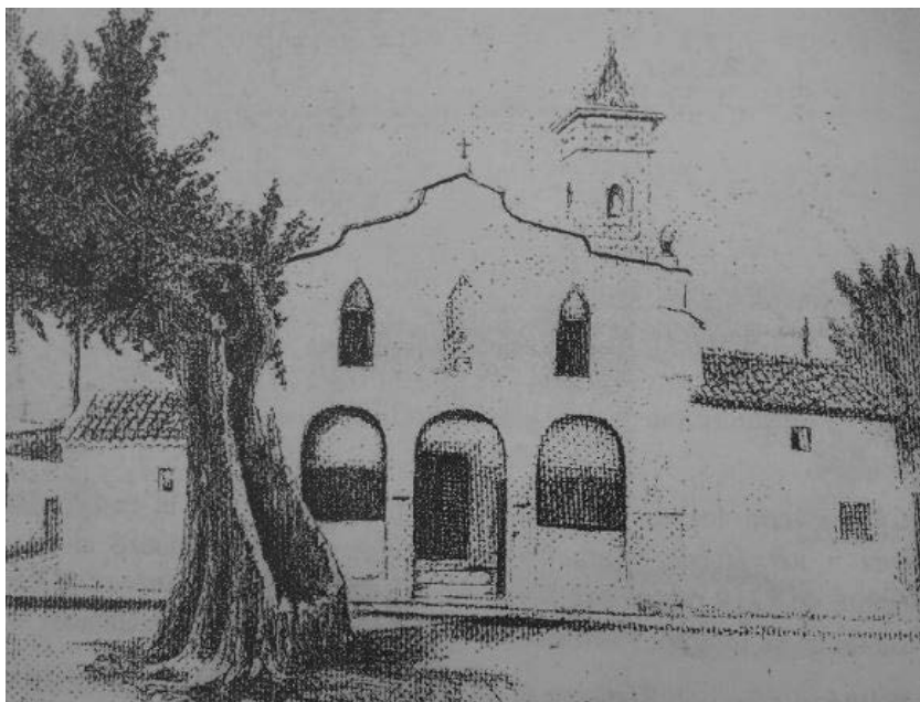
Figura 12. Estado del Olmo del Santo tras la potente tormenta. Obsérvese el tronco hueco y la reducida copa que le quedó (ZAHONERO, 1997)
