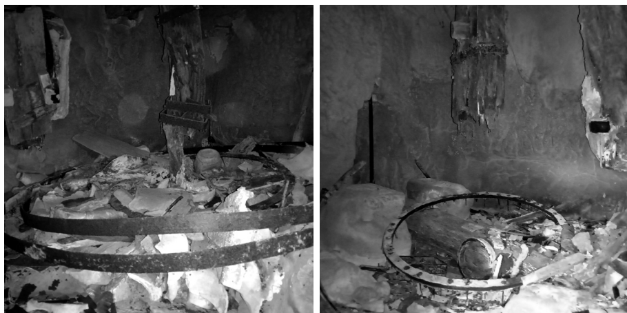
Figura 12 y 13: Restos de los rodeznos en el cárcavo.
