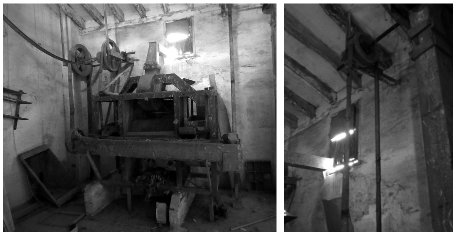
Figura 19 y 20: Máquina de limpia y sistema de poleas en el primer piso.
