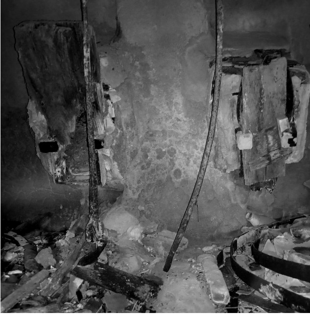
Figura 14: Botanas por donde salía el agua a presión para mover los rodeznos.
