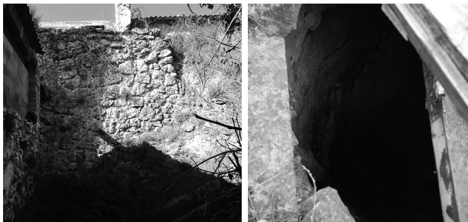
Figuras 10 y 11: Aspecto exterior e interior del cubo.
