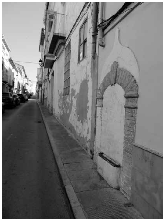
Figura 12. Fuente de San Luis, instalada por demanda del vecindario. Fotografía del autor.
