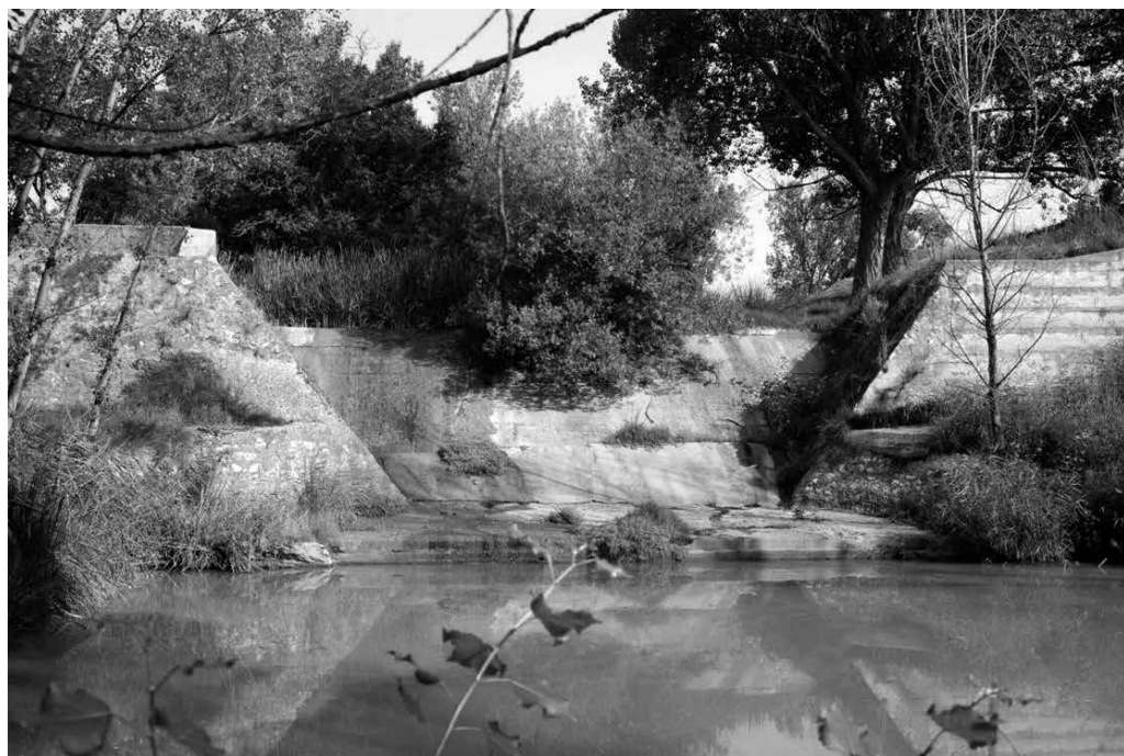
Figura 4. Presa del Judío sobre el río Magro. Fuente: Ignacio Latorre.
