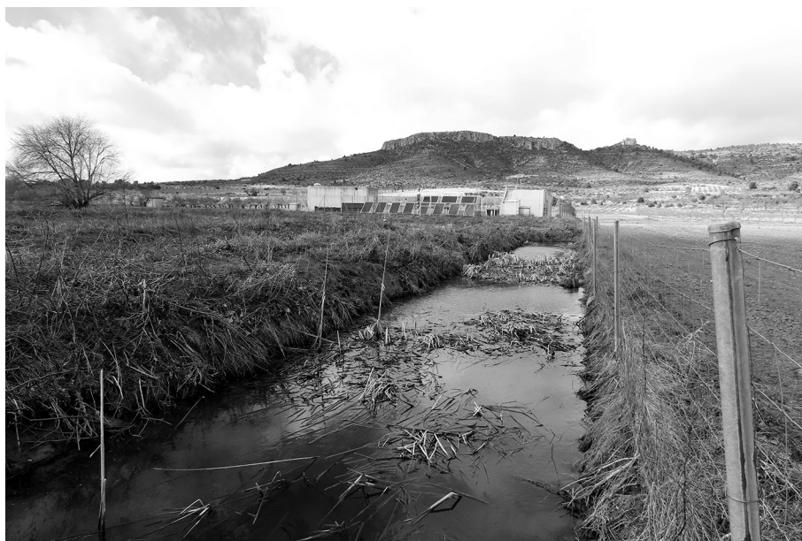
Depuradora de Camporrobles. Foto: Javier Armero.
