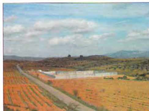
Figura 45. Balsa y canalizaciones en construcción de los nuevos sistemas de riego localizado por goteo.
