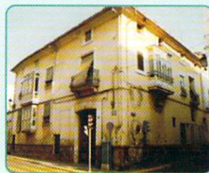
Otro ejemplo de vivienda dieciochescas transformada en el siglo XX, conservando la estructura e incluso el dintel de iluminación del saguán primitivo (Esquina Calle Constitución con Pérez Arce).
