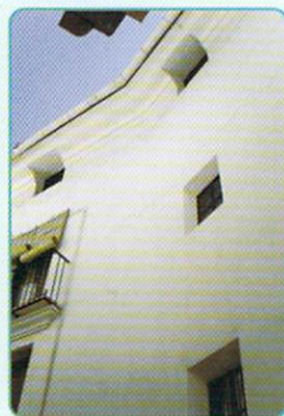
Detalle típico del XVIII en Requena es la interrupción de la cornisa por las ventanillas del "terrazo" (Esquina Rey de Francia-Pérez Galdós, Requena).
