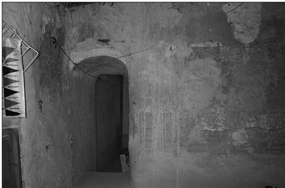
Paso de ronda en torre musulmana (Calle Rosario)
