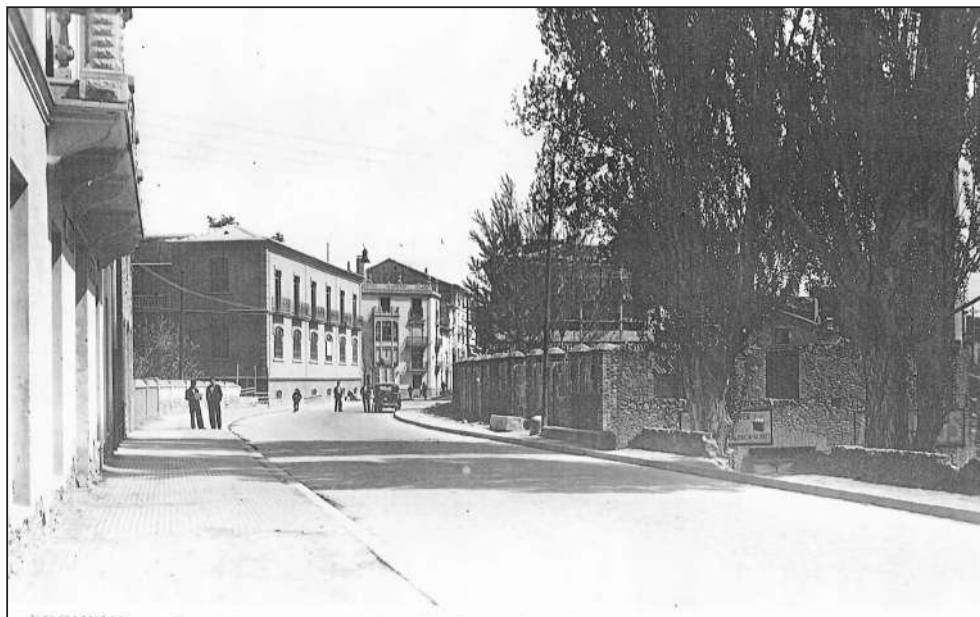
Carretera de las Cabrillas
