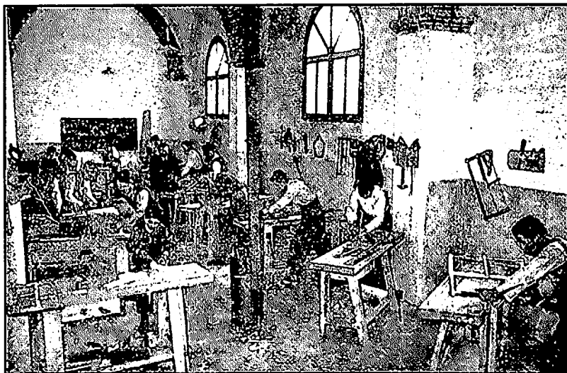
Taller de la Escuela de Orientación Profesional y Aprendizaje en la Avenida Arrabal. El edificio es la actual Biblioteca Municipal
