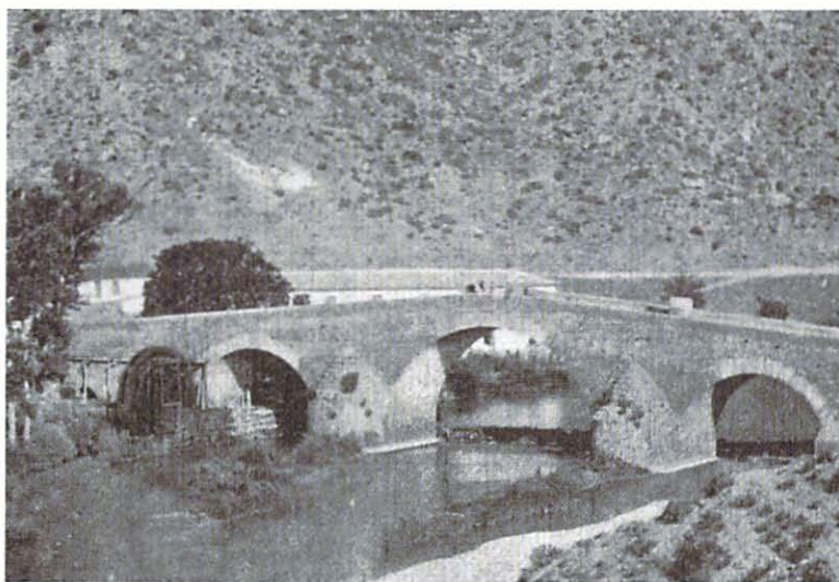
Foto del desaparecido puente del Pajazo, paso principal que comunicaba el Reino de Valencia con la Corona de Castilla. Actualmente sumergido bajo las aguas del embalse de Contreras.
