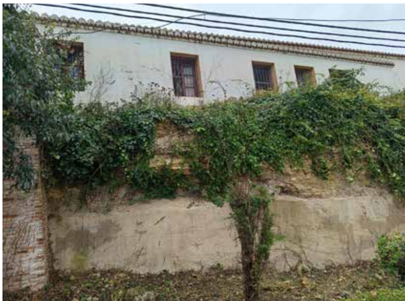
Figura 51. Fachada norte, asentada en el borde de la peña, que fue consolidada tras la restauración de 1982. Fotografía del autor.
