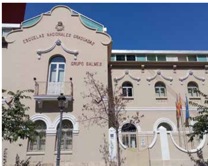
Figura 27. Escuelas Nacionales Graduadas «Grupo Balmes» (1917) en el barrio Ruzafa de Valencia. Obra del arquitecto Antonio López. Actualmente Colegio «Jaime Balmes». Fotografía del autor.
