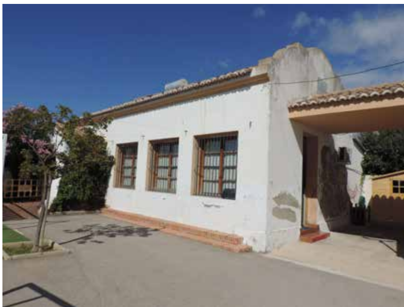
Figura 46. Pabellón de niñas y párvulos. Fotografía del autor.
