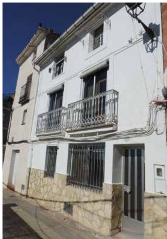
Figura 35. Casa que habitó el maestro durante su estancia en Requena. Fotografía del autor.
