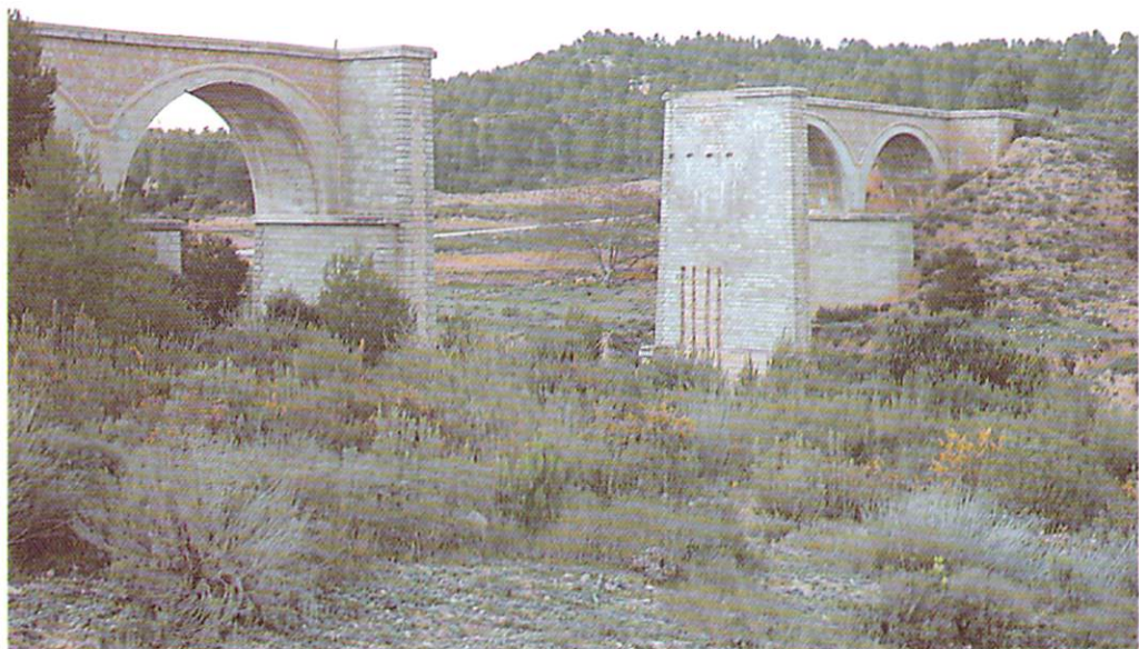
LÍNEA FÉRREA UTIEL-BAEZA: Puente inacabado sobre la rambla de la Bullana, cerca de Casas de Pradas. Las obras de esta línea dieron cierta prosperidad a la zona de la Albosa durante los años 20, pero fueron abandonadas a raíz de la Crisis del 29.
