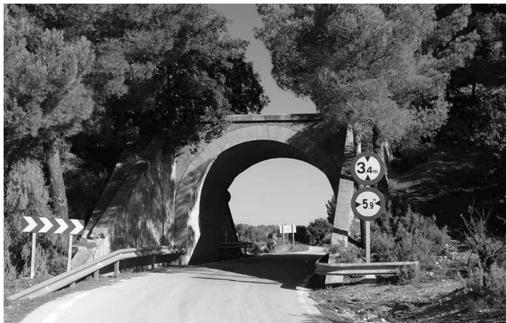
La línea Utiel-Baeza pretendía unir el norte y el sur peninsular sin pasar por Madrid. Era una infraestructura que rompía el modelo de trazado radial de la red de ferrocarriles. Puente de la línea del ferrocarril Utiel-Baeza, sesenta años después de su abandono.
