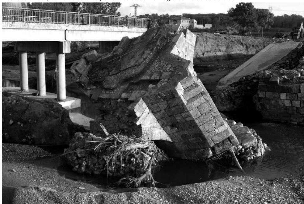
Dstrucción del puente de Jalence por la crecida del río Magro del 29 de octubre de 2024
